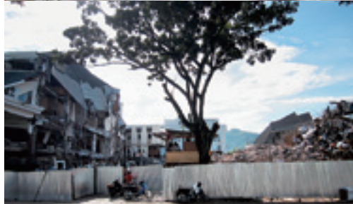
パダン沖の地震で、倒壊した市内の建物。 ⑥は老舗ホテル。数十人が犠牲になった
